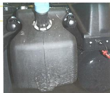
80l-AdBlue-Tank von MAN: Er sitzt gegenüber der Abgasreinigungsanlage
